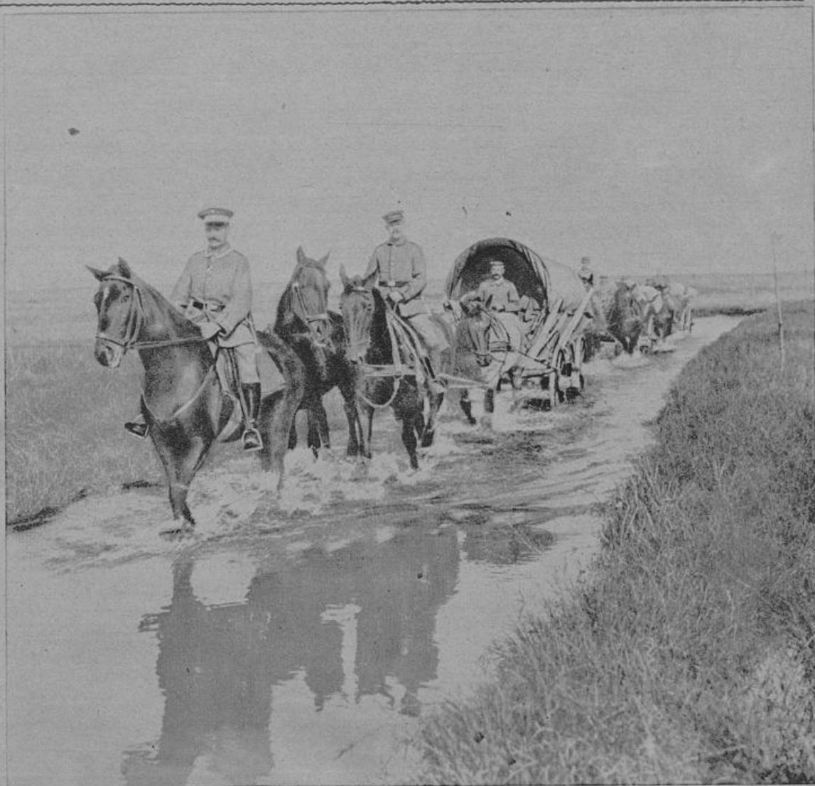
Vom östlichen Kampfgebiet: Deutsche Proviantkolonne im wohnnischen Sumpfgelände.
