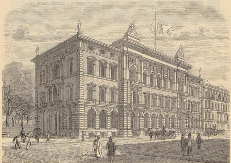
Fig. 195. Gebäude der Preuss. Boden-Kredit-Aktienbank. (Archit. Ende und Böckmann.)
